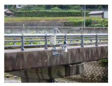
危機管理型水位計 (洪水時の水位観測 に特化した低コスト水位計)
