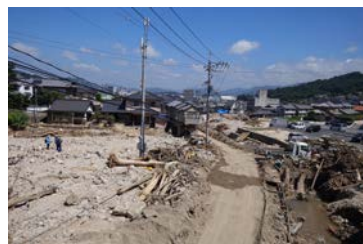
2018年西日本豪雨災害; 広島県坂町、総頭川の扇頂部近傍における土砂・洪水氾濫による被災例
