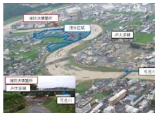
可児市広見の浸水被害状況
