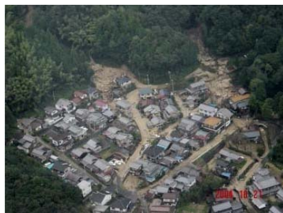
滝馬地区(金引団地)を襲った土石流
