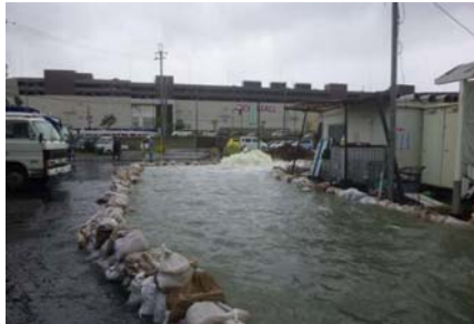
市内の溢水状況
