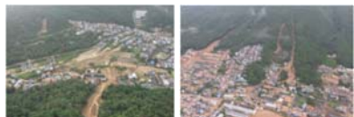
←豪雨災害被災地
