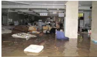
浸水した本庁舎
