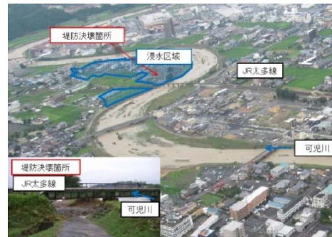
可児市広見の浸水被害状況
