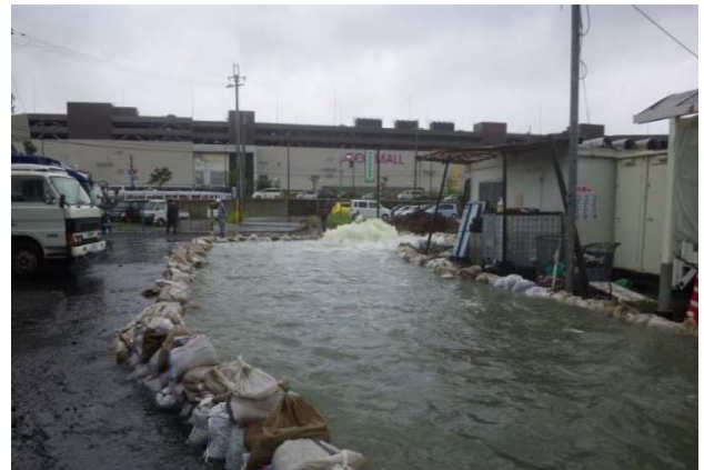
市内の溢水状況
