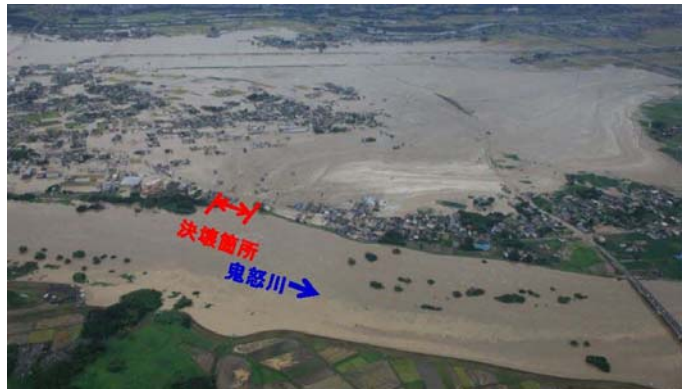
河川の氾濫状況
