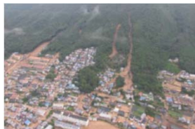
←豪雨災害被災地
